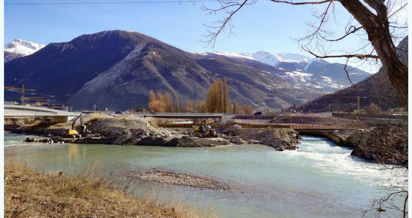
Um die Fischwanderung zu vereinfachen, können Schwellen durch Blockrampen ersetzt werden. Hier die neue Vispa Mündung
